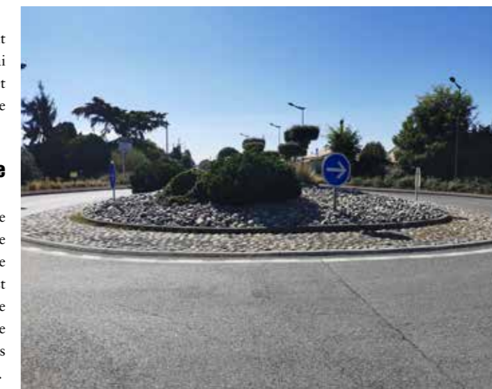
Installation d'une bâche et de galets pour limiter l'entretien du rond-point. Economie de temps estimée : une semaine de travail à l'année d'un agent technique.
