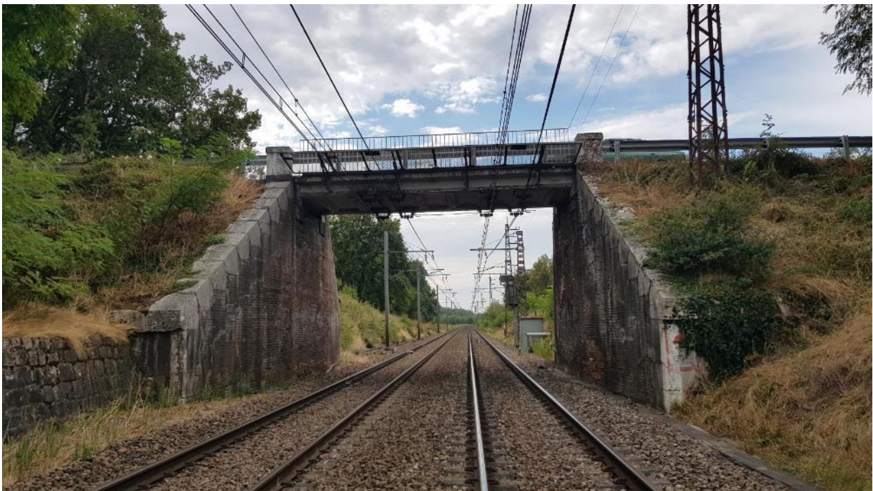
Aperçu de l'ouvrage
