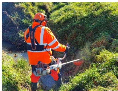
Débroussaillage autour des ouvrages
