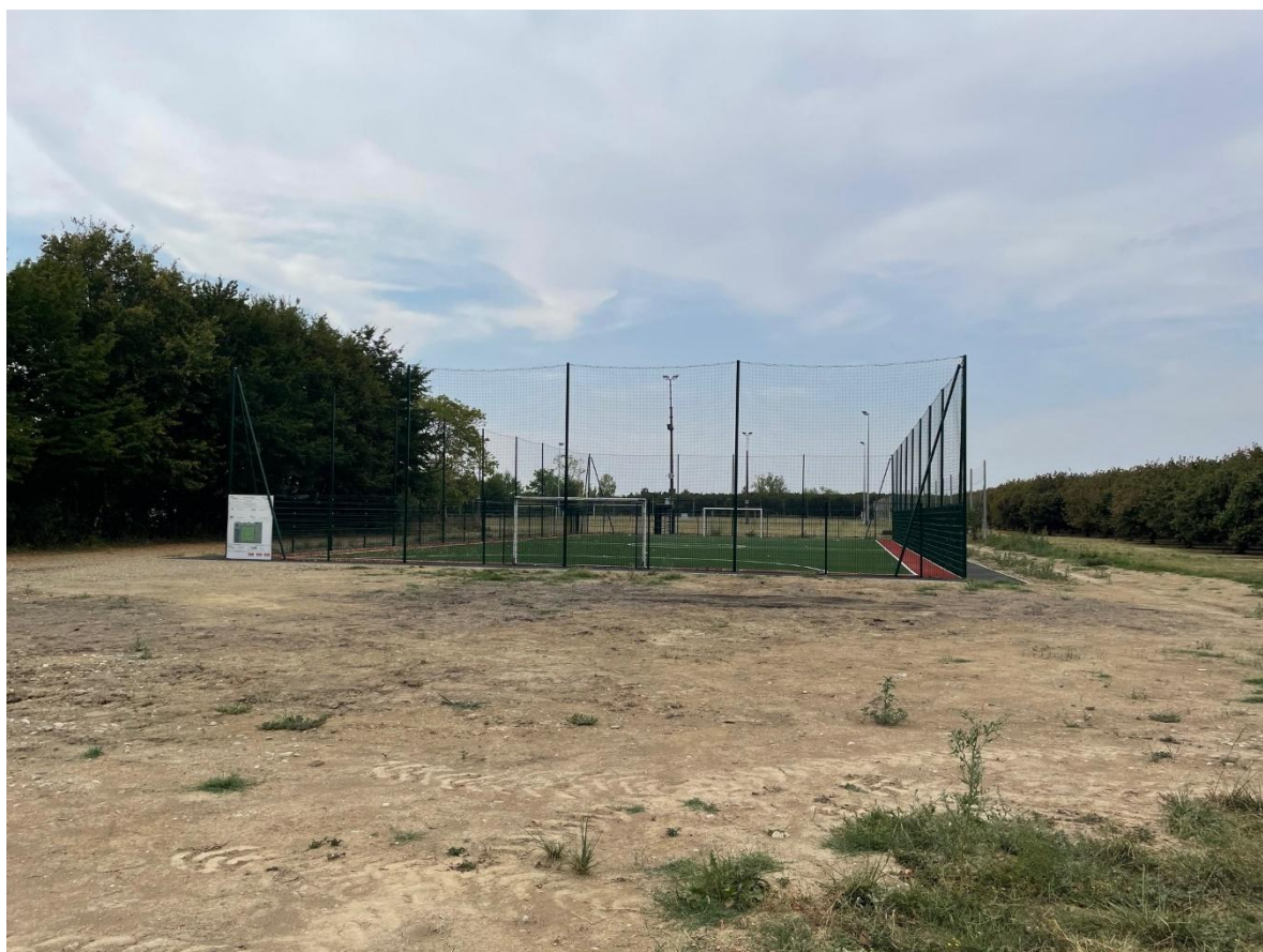
Vue depuis le « parking »
