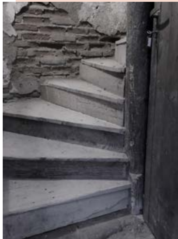
La cage d'escalier de l'Eglise de Bessens
